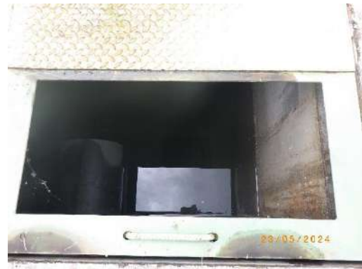
ระบบ OWS ส่วนแยกน้ำมันและส่วนน้ำใส สถานีสูบน้ำมาบตาพุด
