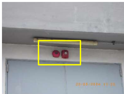
สัญญาณเตือนภัยสำหรับชุมชนที่ สถานีควบคุมระบบท่อที่ 652
