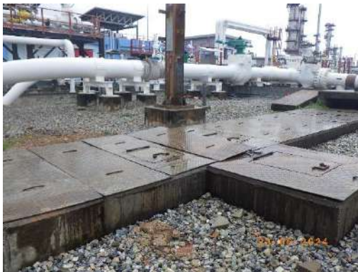
ระบบ OWS ส่วนแยกน้ำมันและส่วนน้ำใส สถานีสูบน้ำมาบตาพุด
