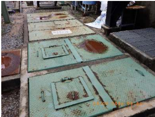
ระบบ OWS ส่วนแยกน้ำมันและส่วนน้ำใส บริเวณสถานีสูบน้ำมาบตาพุด
