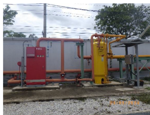
ระบบดับเพลิงอัตโนมัติ สถานีควบคุมระบบท่อที่ 652
