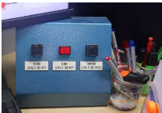
ระบบหยุดป้อนอัตโนมัติ สถานีสูบน้ำส่งน้ำมันมาบตาพุด
