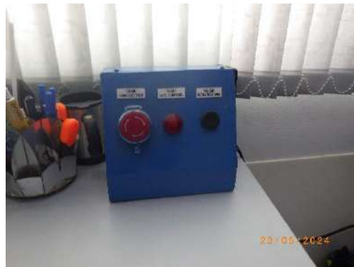
ระบบหยุดป้อนอัตโนมัติ สถานีควบคุมระบบท่อที่ 652
