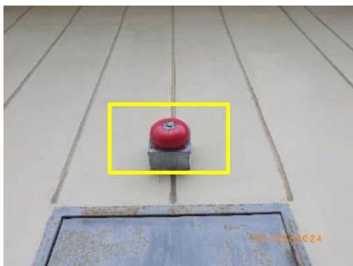
สัญญาณเตือนภัยสำหรับชุมชนที่ สถานีสูบน้ำดิบมาบตาพุด
