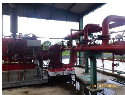
Fire Pump สถานีควบคุมระบบท่อที่ 652
