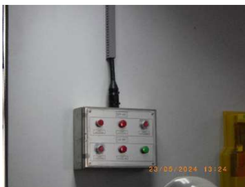
ระบบหยุดป้อนอัตโนมัติ สถานีสูบน้ำส่งน้ำมันศรีราชา
