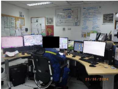
การควบคุมท่อส่งน้ำมันด้วยระบบ SCADA สถานีสูบน้ำมันมาบตาพุด
